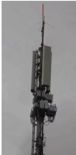
Unten an den Breitband-Antennen sind oft eine Menge kleiner, würfelförmiger Böxlein zu finden. Es sind dies Speisegeräte, Sender-Endstufen und neuerdings auch Bluffer-Boxen.
