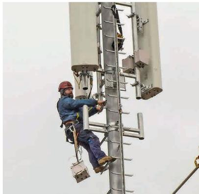
Bild oben: Montage von Bluffer-Boxen
