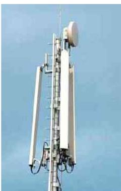
typische Mobilfunkbasisstation mit drei Sektorantennen und Richtfunk
