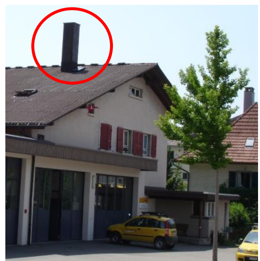
Als Kamin getarnte Mobilfunkantenne.
