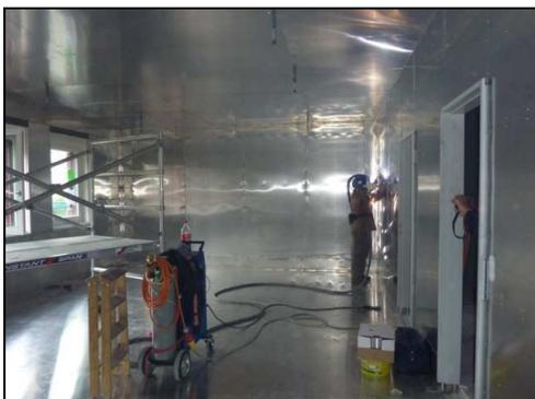
Bild links: Hier entsteht nicht etwa eine ausbruchsichere Gefängniszelle, sondern ein vollständig abgeschirmter Büroraum eines Staatsanwaltes. Boden, Wände, Decke, alles mit 2mm dicken Aluminiumplatten unterlegt von zwei verschiedenen Siliziumplatten. Wer nicht glauben möchte, dass es sich um Metallplatten handelt, sehe dem Schweißer zu, welcher die Fugen zwischen den einzelnen Blechen sauber verschweisst.
